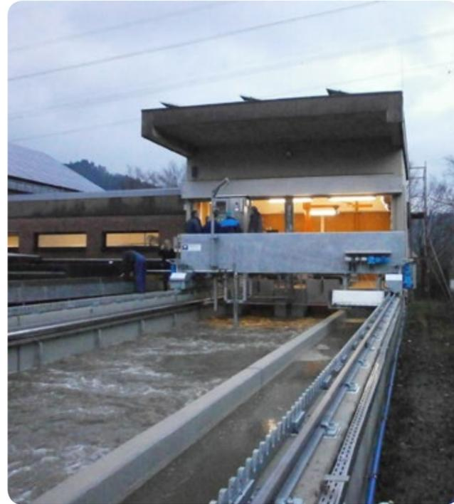
Für die Entnahme des Primärschlammes aus dem Vorklärbecken und für die Abtrennung des Schlammes aus dem Nachklärbecken liefert hoelschertechnik-gorator® GmbH & Co. KG Räumeinrichtungen für Bodenschlamm für einen effektiven Betrieb.
