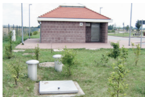
Pumpstationen an der Autobahnraststätte
