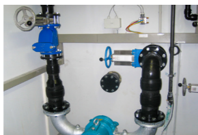
Nachrüstung Drehkolbenpumpe zur Erhöhung der Förderleistung
