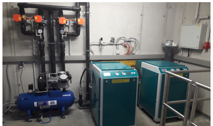
Kompressor mit Prozessluftführung
