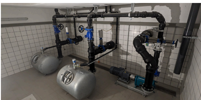
GULLICOMB® mit Drehkolbenpumpe
