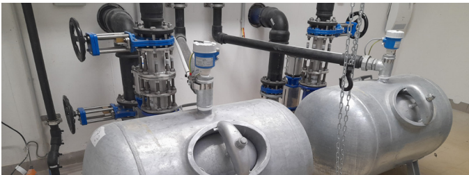
Arbeitsbehälter mit Armaturensatz
