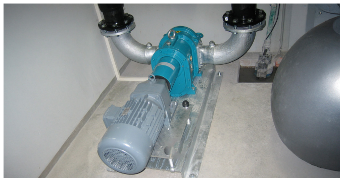
GULLICOMB® mit Drehkolbenpumpe
