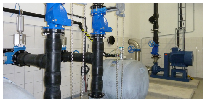
GULLICOMB® mit Einkanalradpumpe
