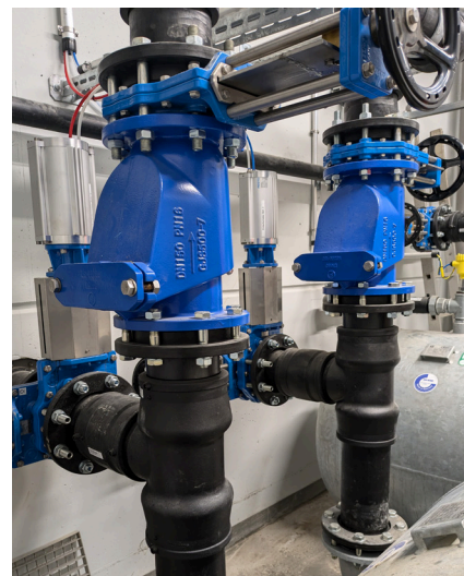
Armaturensatz mit Behälterverrohrung
