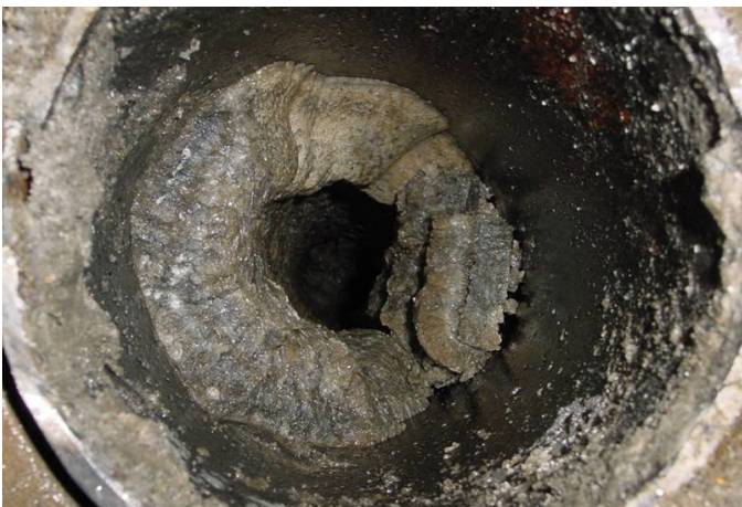
Sielhautbildung in der Rohrleitung
