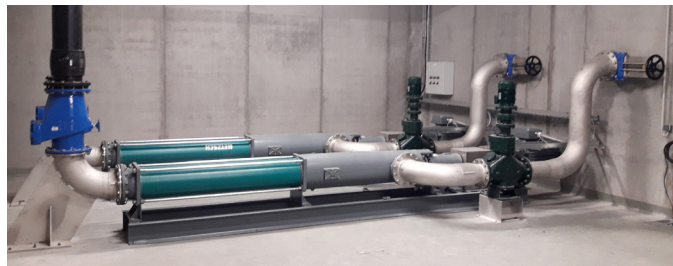
GULLICOMB® mit Exzentrerschnellenpumpe
