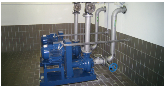
Trocken aufgestellte Pumpen
