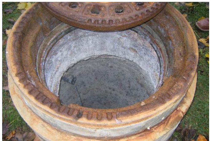
Durch Schwefelsäure-Korrosion angegriffener Betonschacht
