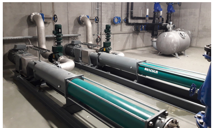
GULLICOMB® mit Exzentrerschneckenpumpe
