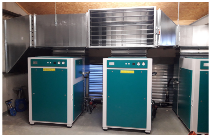
Kompressor mit Abluftsystem
