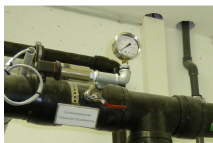
Optionale Druckerfassung in der Rohrleitung
