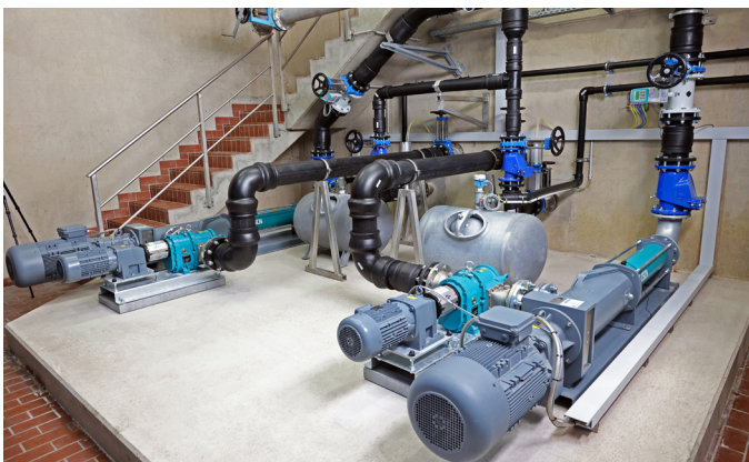
GULLICOMB® mit Exzentrerschneckenpumpe
