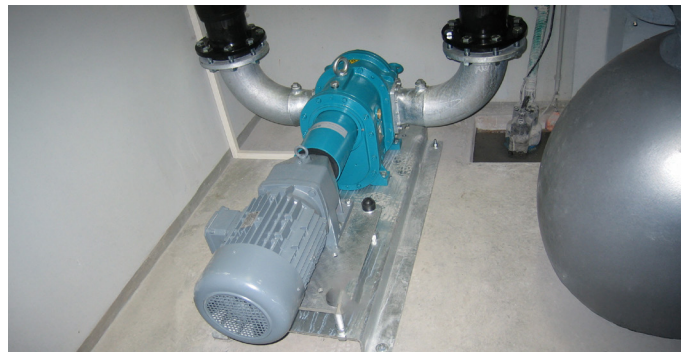
GULLICOMB® mit Drehkolbenpumpe
