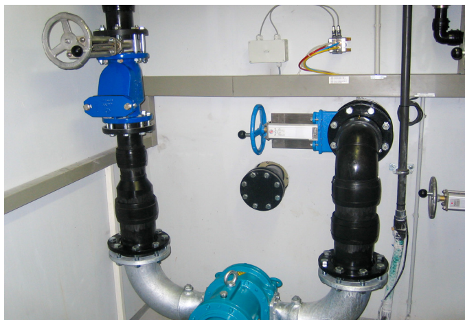
Nachrüstung Drehkolbenpumpe zur Erhöhung der Förderleistung
