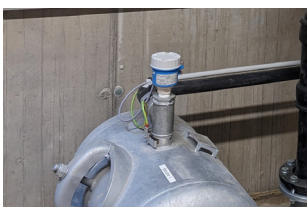
Kapazitive Füllstandsmessung
