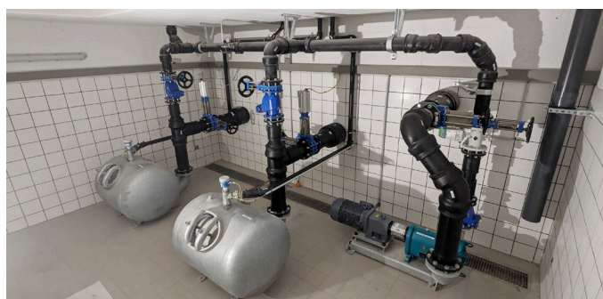
GULLICOMB® mit Drehkolbenpumpe
