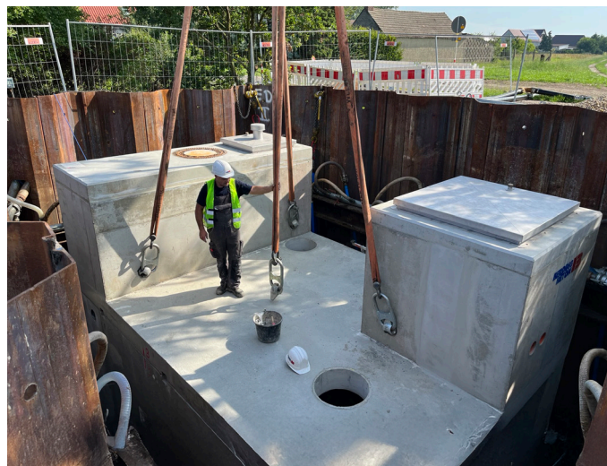
Anlagenraum eines Pumpwerks GULLIVAC® in Kombination mit einer Vakuumanlage
