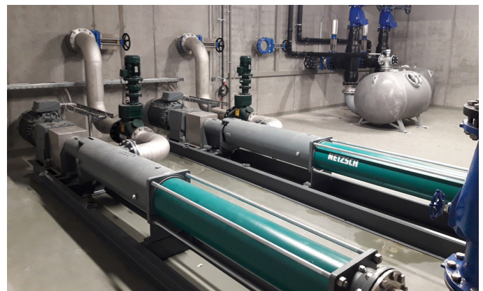
GULLICOMB® mit Exzentrerschneckenpumpe
