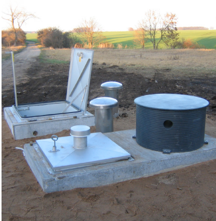
Außenansicht des Pumpwerkes
