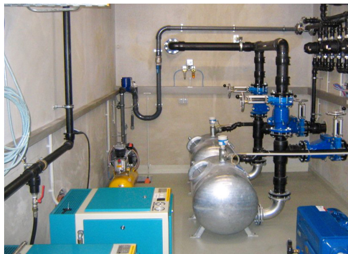
Anlagenraum eines Pumpwerks GULLIVAC® in Kombination mit einer Vakuumanlage
