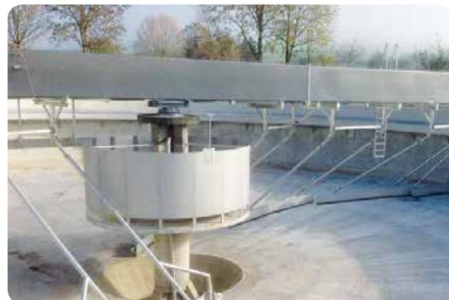
Mit der langjährigen Erfahrung unserer Mitarbeiter bieten wir entsprechend den Anforderungen für verschiedene Beckenformen bewährte Lösungen für die Räumung von Boden- und Schwimmschlamm. Unterschiedliche Antriebssysteme mit Lauf- oder Schienenrädern garantieren auch mit einem Zwangsantrieb einen problemlosen Winterbetrieb.
